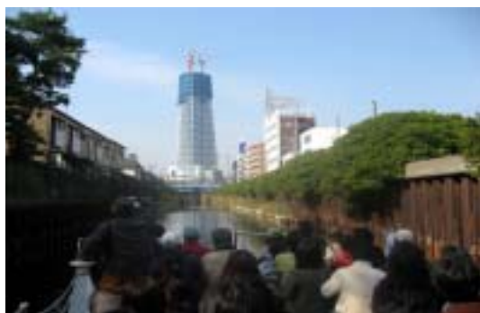
建設中の東京スカイツリーを遠望
